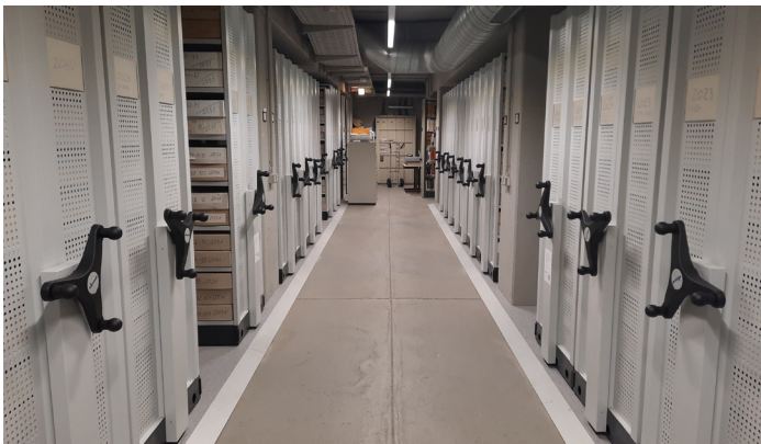
Die neue Rollregalanlage nach dem Einbau.
