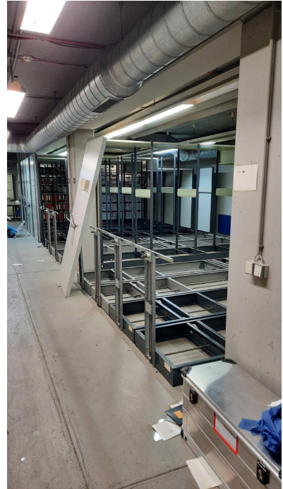
Demontage der defekten, fast 40 Jahre alten Rollregalanlage
